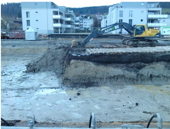
Über die Abflussrohre wird das abgepumpte Wasser in ein Setzbecken geleitet (hinten links, neben Zelt) und von dort aus dem Friedgrabenbach oder der Kanalisation zugeführt.
