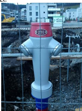
Danach wurde sogleich mit dem Aushub begonnen; das Bild zeigt eindrücklich auf, wie lehmig und wasserhaltig der Boden ist. Bereits wurde ein erster Hydrant gesetzt.
