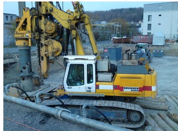
18. April 2010: Ein riesiges Gefährt kommt auf den Platz, welches die Pfähle in den Boden rammen wird, damit das Gebäude auf sicherem Fundament errichtet werden kann.
