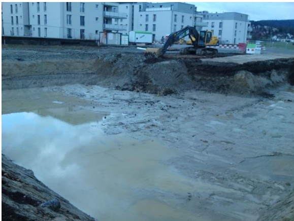
Danach wurde sogleich mit dem Aushub begonnen; das Bild zeigt eindrücklich auf, wie lehmig und wasserhaltig der Boden ist. Bereits wurde ein erster Hydrant gesetzt.
