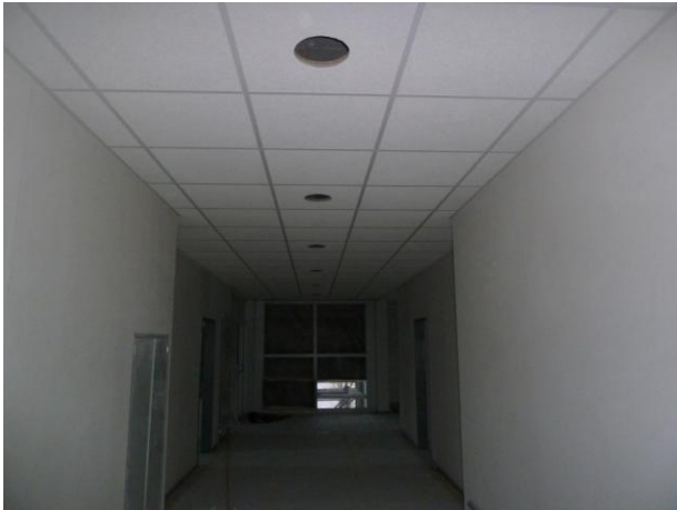
13. November 2011: Auch in den Korridoren sind die Decken nun fertig eingebracht (hier im OG); deutlich zu erkennen sind die Aussparungen für die Lampen.
