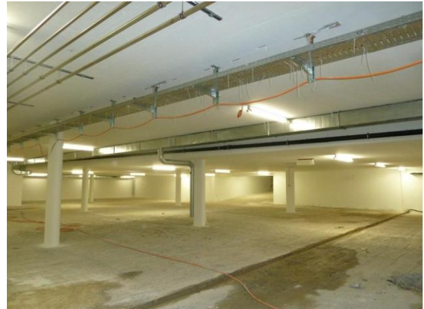
Die Tiefgarage erstrahlt im Lichterglanz: Die Säulen, Wände und die Decke sind weiss gestrichen worden und Lampen leuchten das bisher dunkle Loch aus.
