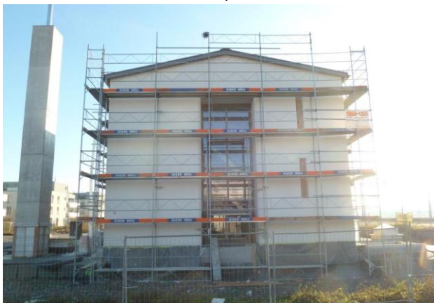
Der gesamte Haupteingangsbereich ist nun verglast.
