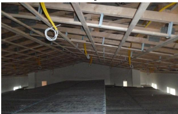
19. November 2011: In der Kapelle wird die Lattung zur Anbringung der Akustikdecke montiert.
