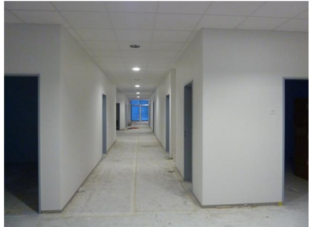
20. Dezember 2011: Im Korridor des EGs sind die Lampen bereits montiert worden....
