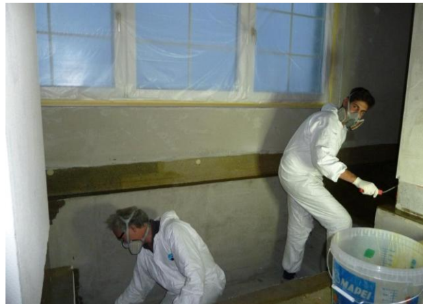
Im Taufbecken sind Grundierungsarbeiten im Gang.
