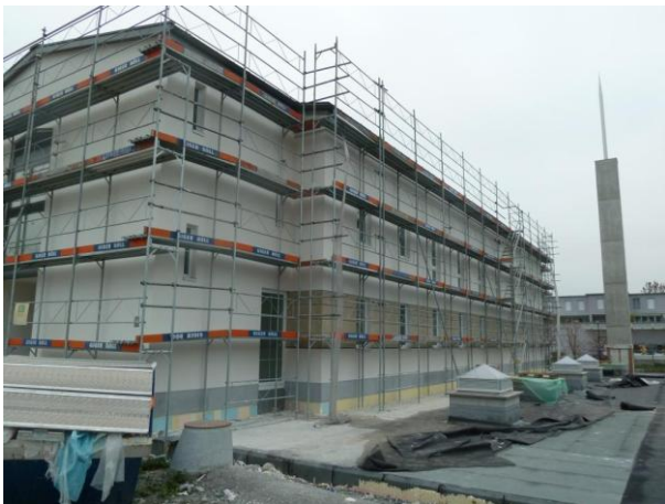
... und die Fassade geht ihrer Vollendung entgegen: Schon deutlich zeichnet sich das das Zierband im Bereich des EGs ab, das herausgearbeitet wird.
