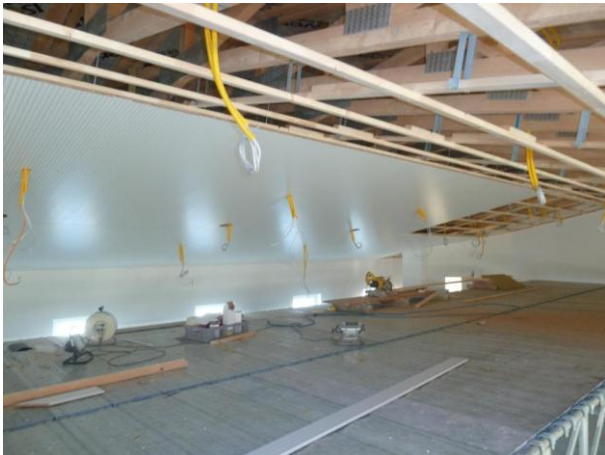
Hier das halbfertige Produkt; etwa eine Woche später ist die Decke fertig erstellt.
