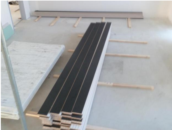
27. November 2011: Im OG liegen neben der Kapelle die Elemente der Akustikdecke zur Montage bereit.
