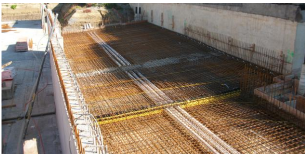
20. September 2010: Zwei Wochen später sind die Eisen gelegt, damit die Zufahrt betoniert werden kann.
