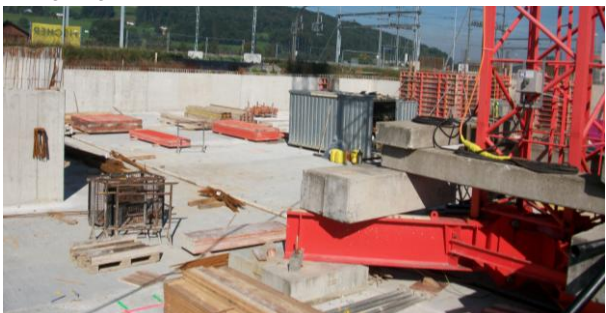
Die Tiefgaragenwände sind nun schon beinahe rundherum betoniert, und auch der...
