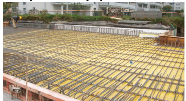
15. Oktober 2010: Die Decke über der Tiefgarage ist schon beinahe fertig betoniert; dieser Vorgang erfolgt in vier Etappen: 1. Drittel westlich; 2. Drittel östlich; 3. Drittel in der Mitte, dort, wo das Gebäude drauf errichtet wird (hier gerade im Prozess, hinter der roten Schalung), und viertens die Überdeckung der Zufahrt, für die hier gerade die Eisen gelegt werden (siehe unten).
