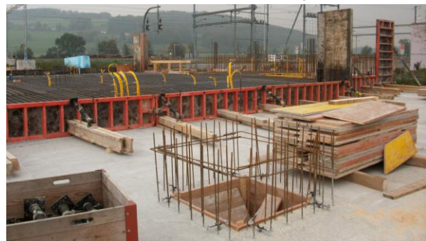
15. Oktober 2010: Die Decke über der Tiefgarage ist schon beinahe fertig betoniert; dieser Vorgang erfolgt in vier Etappen: 1. Drittel westlich; 2. Drittel östlich; 3. Drittel in der Mitte, dort, wo das Gebäude drauf errichtet wird (hier gerade im Prozess, hinter der roten Schalung), und viertens die Überdeckung der Zufahrt, für die hier gerade die Eisen gelegt werden (siehe unten).
