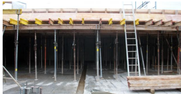
Derweil wird westlich bereits die Decke geschalt.
