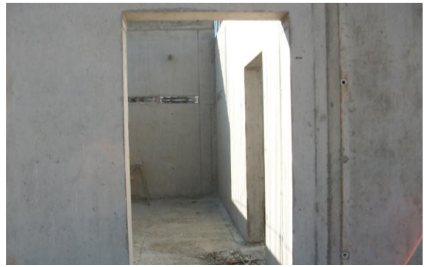
... Eingang zum südlichen Treppenhaus ist fertig.
