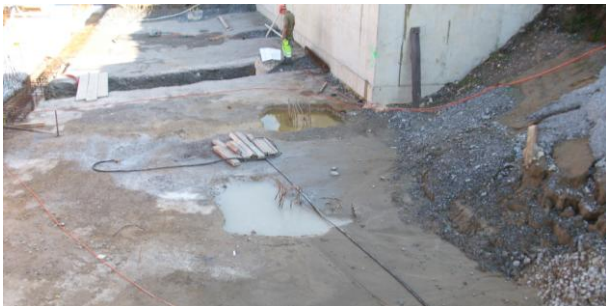
In diesem Bereich hier wird die Rampe zur Zufahrt für die Tiefgarage vorbereitet (hinten beim Bauarbeiter) und ebenso der Anschluss an die Tiefgarage für die Gewerbebauten, die südlich errichtet werden (vorne).
