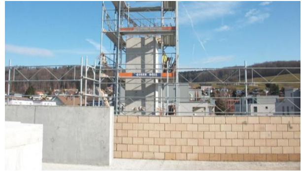
11. Februar 2011: Der Turm wächst bereits über das Dachgeschoss hinaus, wo wir uns jetzt befinden;
