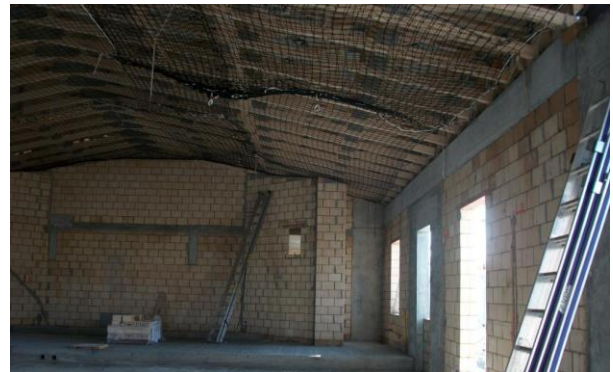
... mit Zimmermannsarbeit für den Dachaufbau.
