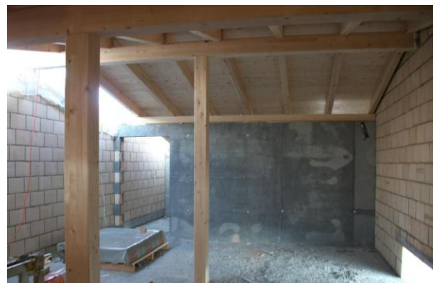
Hier die Holzkonstruktion im Dachgeschoss.
