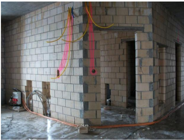
Überall zieht jetzt der Elektriker die Stromkabel ein.
