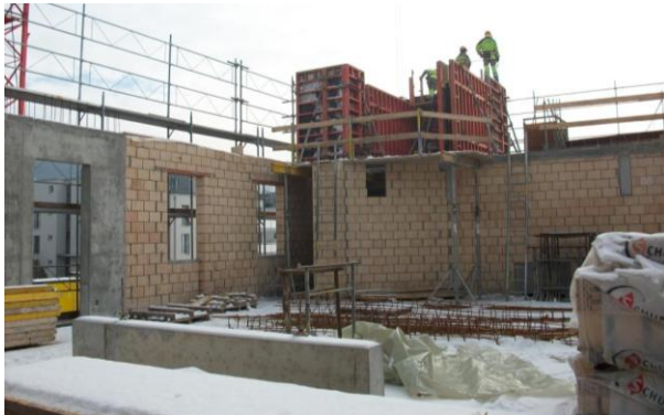
In der Kapelle liegt Schnee und die Arbeiter nehmen das Dachgeschoss in Angriff.
