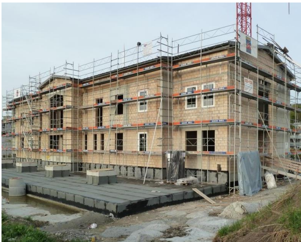
11. April 2011: Der Einbau der Fenster beginnt...
