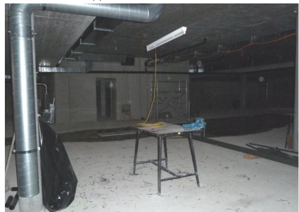
Unterniveaugarage mit kleiner Werkbank.
