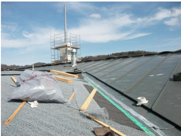
21. März 2011: Auf die Strukturmatte wird nun das schiefergrau-farbene, vorbewitterte Kupfertitanzinkblech verlegt, welches den Dachabschluss bildet.
