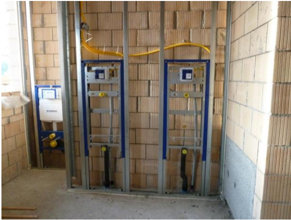
... wie auch das Grundgerüst für die Toiletten.
