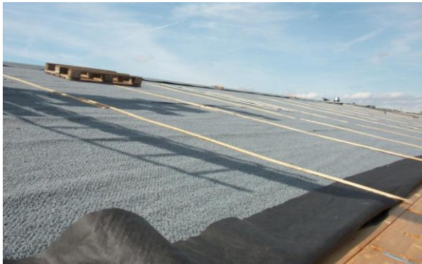
Am 15. März kann der Spengler mit den Bedachungsarbeiten beginnen; zuerst wird eine Strukturmatte verlegt, welche schalldämmend wirkt sowie Kondensat absorbiert.
