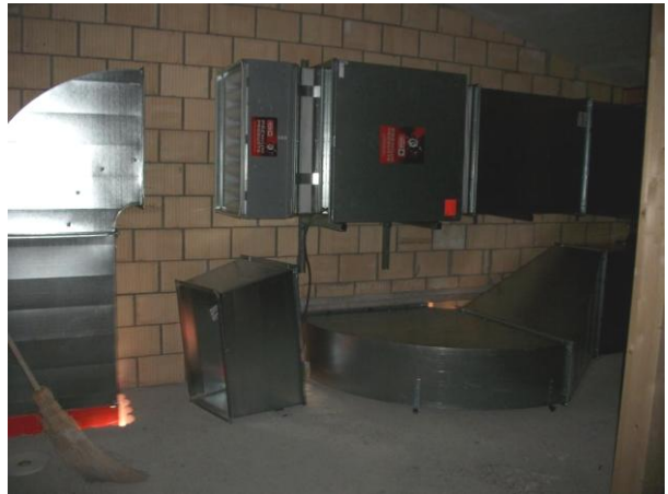
Die Installation der Lüftungskanäle ist am 4. April grösstenteils abgeschlossen.
