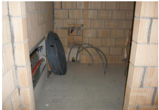
Ebenso hat der Sanitär- und Heizungsinstallateur die Heizungs- und Sanitätsverteilkästen eingebaut.
