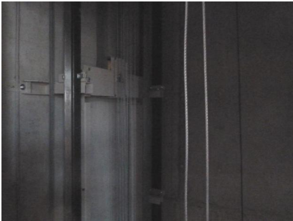
Seit dem 4. April wird auch der Lift eingebaut.
