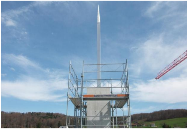
7. März 2011: Ein Jahr nach dem Spatenstich wird die Spitze auf den Turm gesetzt.
