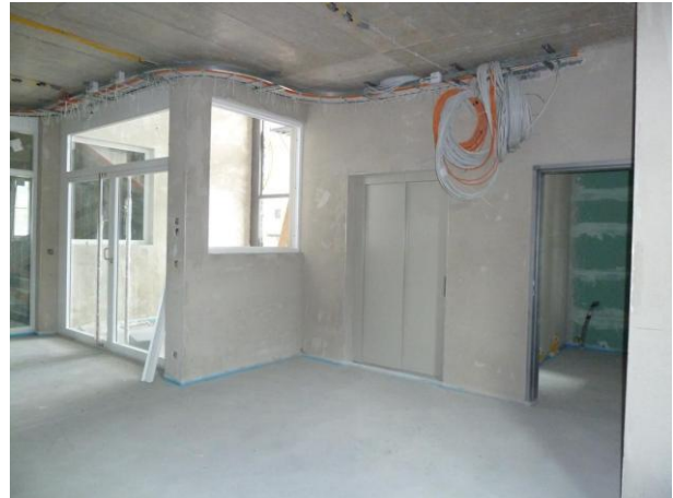
Die Haupteingangspartie mit Windfang, Lift und Abwartraum 1.
