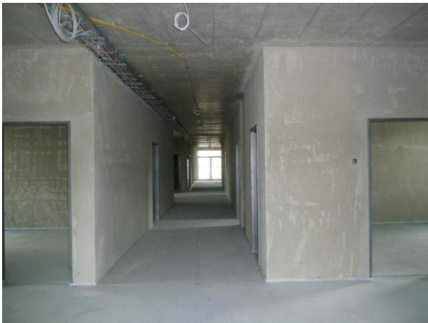
Blick vom Hinterausgang im Süden Richtung Haupteingang im Norden. Links und rechts im Vordergrund die beiden Bischofschaftszimmer. Der Unterlagsboden ist nun überall eingegossen.
