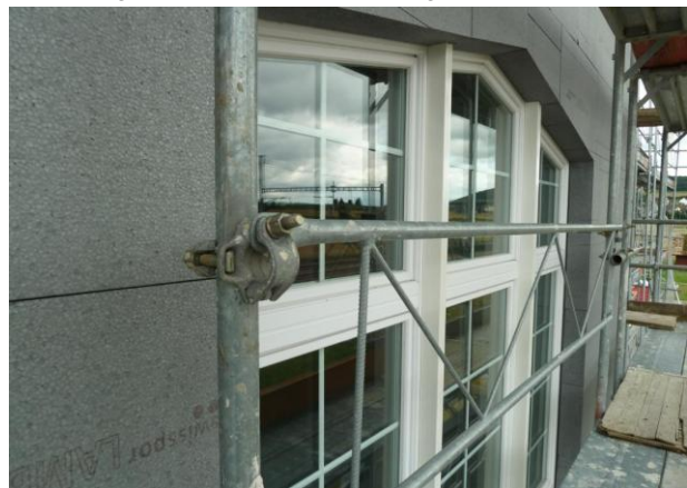
Kapellenfenster vom Baugerüst aus; deutlich erkennbar ist die Aussenisolation.
