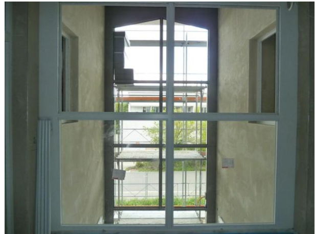
Hier der gleiche Windfang, jedoch vom ersten OG aus.
