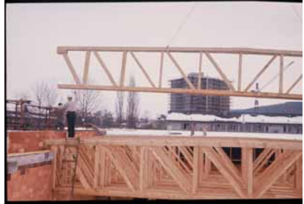
Die vorgefertigten Binder werden gesetzt.
