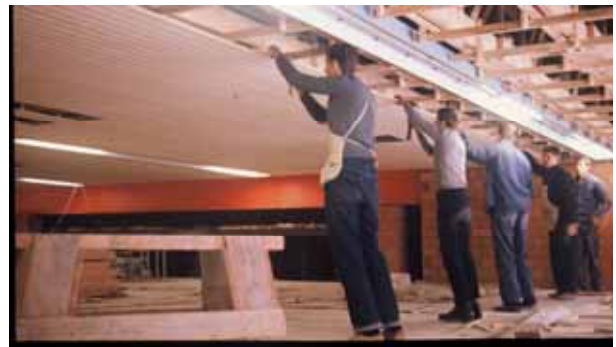
Und jetzt heisst's täfern, was das Zeug hält...
