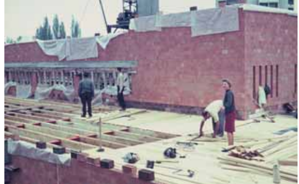
Das Dach nimmt Form an.
