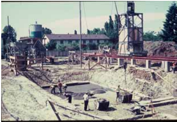
Arbeiten am Fundament; im Hintergrund die Kranbahn.
