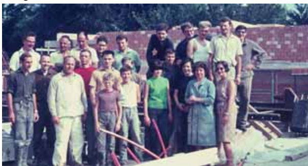
Die Decke über dem Keller ist betoniert; erste Wände aus Sichtbacksteinen werden hochgezogen.
