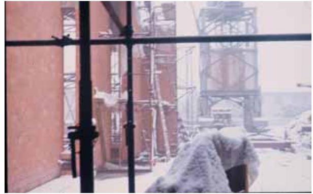
Winter auf der Baustelle.
