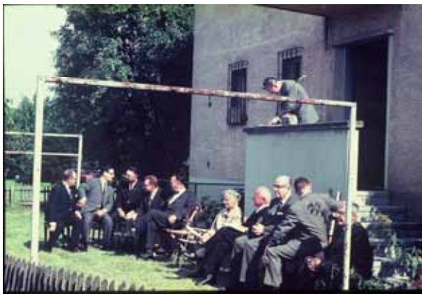
Hinter verrosteter Waschleinvorrichtung warten die geladenen Gäste, unter anderem Stadtpräsident Dr. Emil Landolt und Apostel Ezra Taft Benson, auf den Beginn der Spatenstichzeremonie.
